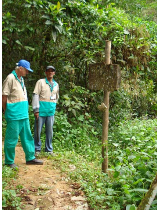
Fixação de novos postes
